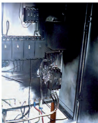
Рис. 14 Выход из строя варисторного УЗИП привел к пожару в ГРЩ.
